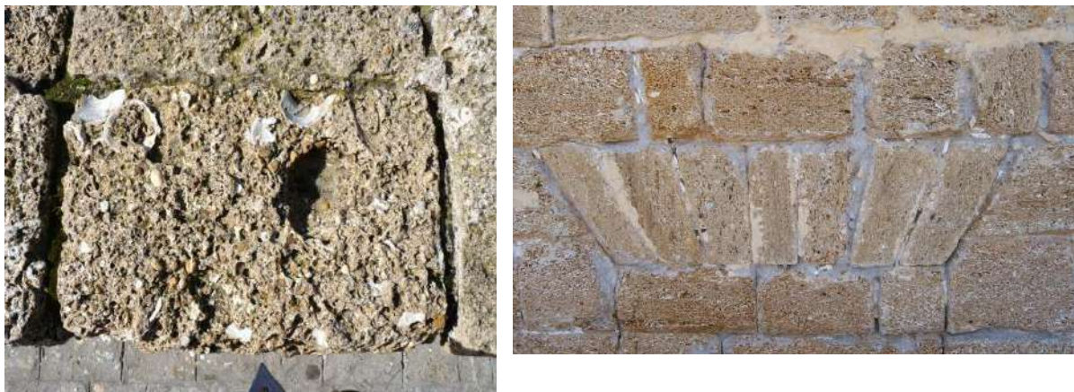
Foto 3. Detalle de sillería de Piedra Ostionera. Se aprecian los ostiones y su despiece sin aristado claro.
