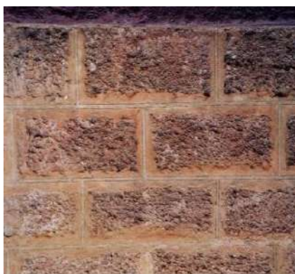
Foto 11. Uso de la piedra ostionera en la casa gaditana. Dibujo de autor. Tratamiento de protección y estético sobre piedra ostionera. Catedral y casa de San Fernando.
