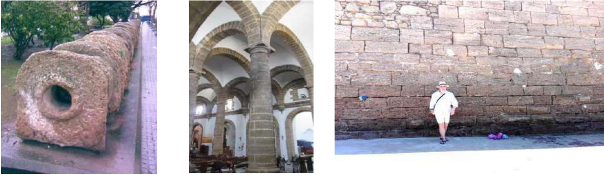
Foto 5. Diferentes utilizations de la piedra ostonera como edificación en Cádiz. Duelas del acueducto romano, Catedral Vieja y muralla de cortadura.
